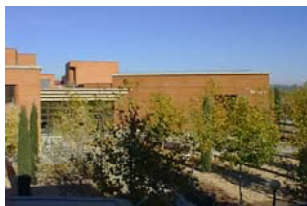
EDIFICIO ENRIQUE COSTA NOVELLA Ingeniería Química
