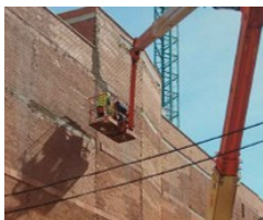
Ejecución de enfoscado en altura mediante brazo articulado con cesta y trabajadores atados
